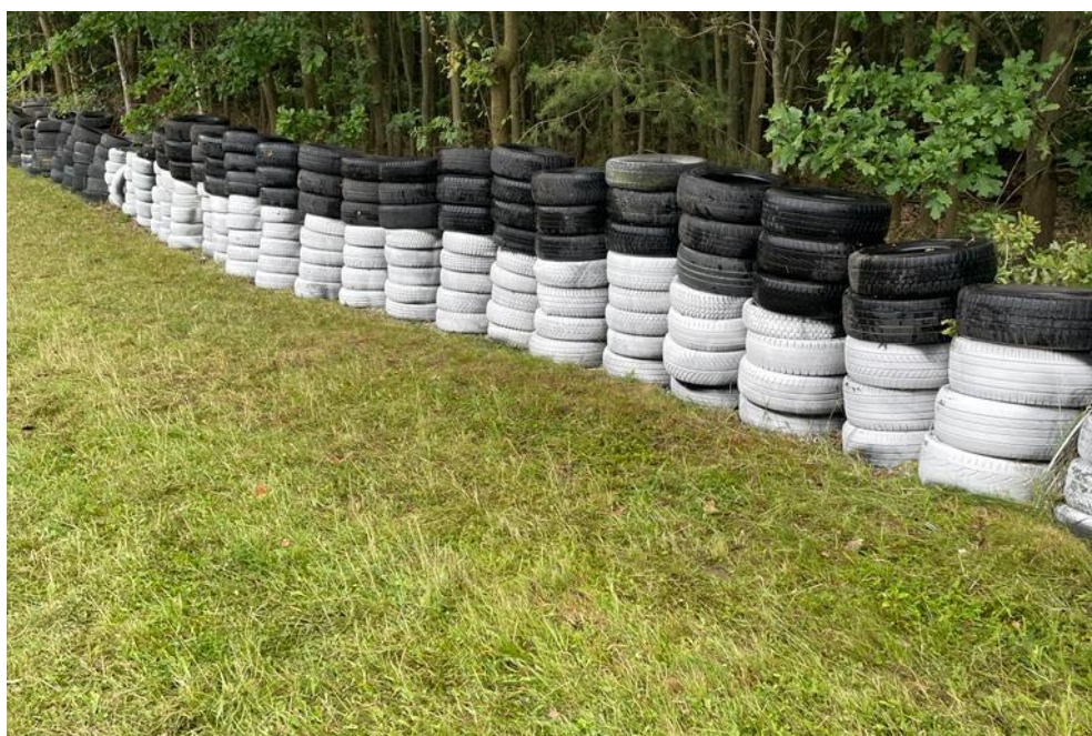
Obrázek 6 Doplněná bezpečnostní bariéra na výjezdu po pravé straně ze zatáčky č. 2
